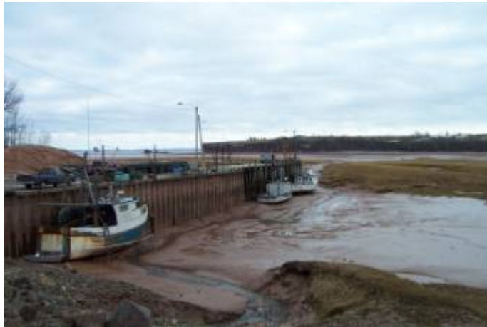
Photo R. Héту (port de Delhaven)
