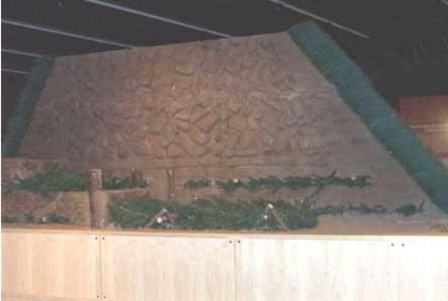
Maquette au lieu historique de Grand-Pré, illustrant le parement extérieur de la digue composé de mottes uniformes, de végétation vivante, placées minutieusement comme des briques. L'intérieur de la digue est rempli de mottes pêle-mêle. A la base et surtout pour l'aboiteau du sapinage bien ancré empêche le glissement de l'ouvrage.
